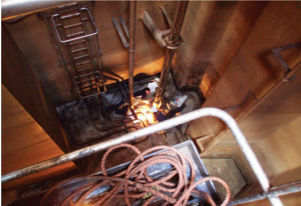
الشكل رقم (2) : خزان ناقلة مواد كيميائية/منتجات، أثناء عملية الإصلاح والصيانة
