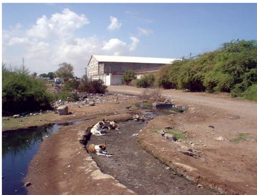
Figure 9. Eaux usées brutes déversées directement dans la mer via un canal près des abattoirs.
