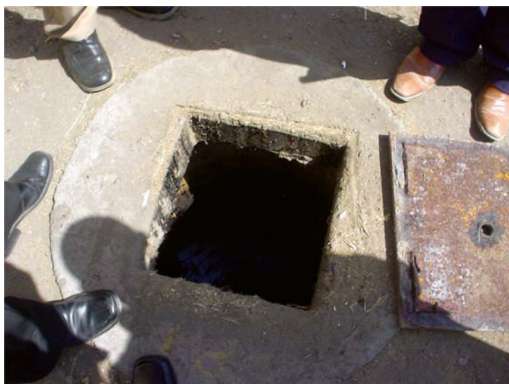
Figure 2. Forage de puits dans le port pour l'extraction de pétrole.
